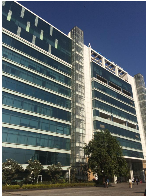
新コンタクトセンター 外観
